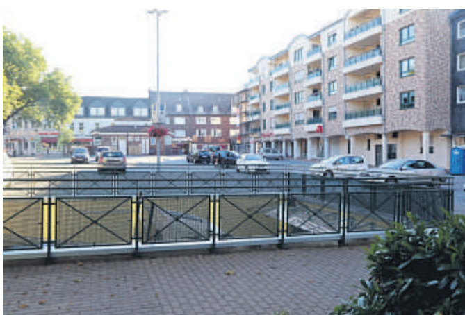
Auch das Erscheinungsbild des Marktplatzes ist durch den Neubau samt Tiefgarage besser geworden.
