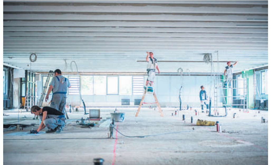
In den Sommerferien wurde mächtig gearbeitet in der Gesamtschule.
